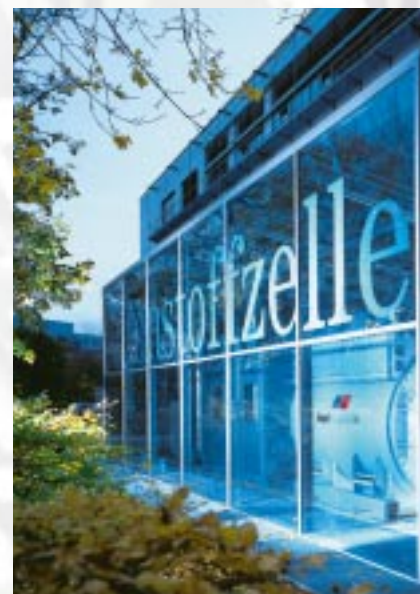
Die MTU Brennstoffzelle der DeTeImmobilien in München.
